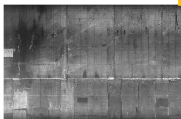
写真3：変状関連箇所の除去 (写真2 青枠部のみを除去)
